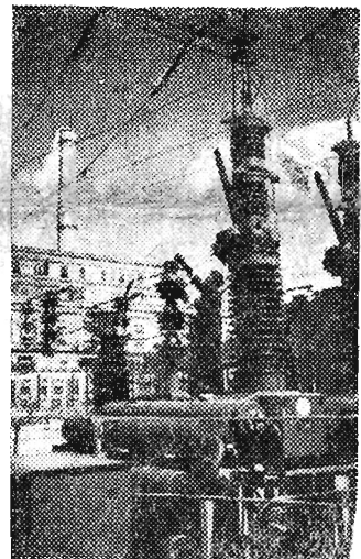
Na zdjęciu: Nowoczesna potężna elektrownia Jaworzno II. CAF — fot. Kondracki
