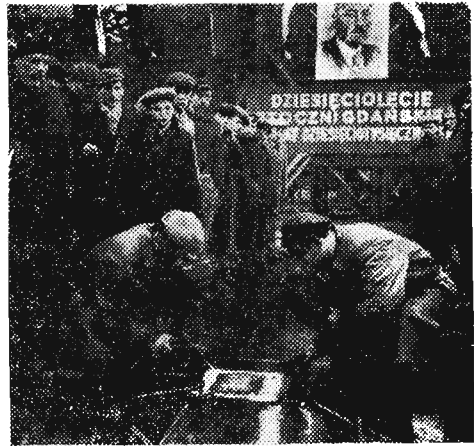
Na zdjęciu: Przewodzący spawacz z wydziału K-III Stanisław Plaszyński i Czesław Bielecki rozpoczynają budowę statku od spawania styku z pierwszym pasem poszycia dennego.
