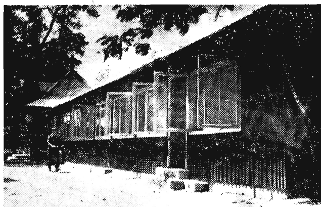
Na zdjęciu: wyremontowana i „zapłęta na ostatni gwizd” kawiarnia w przeddzień otwarcia.
