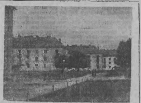
W szybkim tempie posuwają się prace przy budowie pierwszego socjalistycznego miasta Nowa Huta, Tysiące robotników bierze udział w długofalowym współzawodnictwie pracy, pragnąc w ten sposób szybciej zakoczyć budowę.
