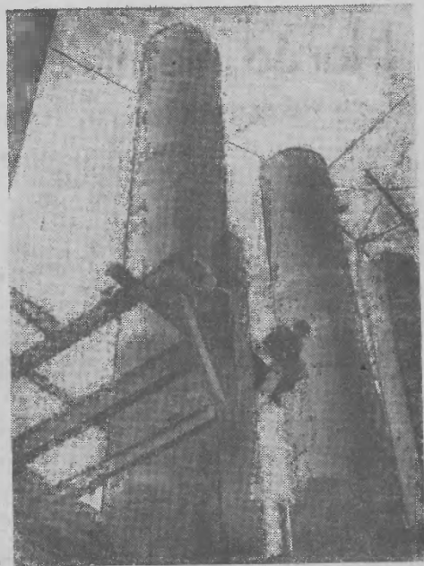
Bez przerwy trwają prace przy budowie wielkiego kombinatu przemysłu azotowego w Kędzierzynie. Na zdjęciu: Monterzy Maksymilian Stekman i Zygmunt Jach z młodzieżowej brigady ZMP-owskiej Mieczysława Gruski, w koniującej 180 proc. normy, podczas montażu płuczek. CAF — fot. Kondradk
