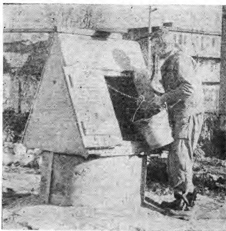
Ta studnia stanowi własność państwa Dołęgów z Ostrowa koło Przemyśla. Wybudował ją ojciec obecnego właściciela w 1917 roku. Nie zdarzyło się, by kiedykolwiek zabrakło w niej zdrowej wody. Przed laty studnia miała 7 kręgów, ostatnio jednak, z uwagi na obniżenie się wód gruntowych, pogłębiono ją o dodatkowy krąg. Fot. T. ZIEMBOLEWSKA
