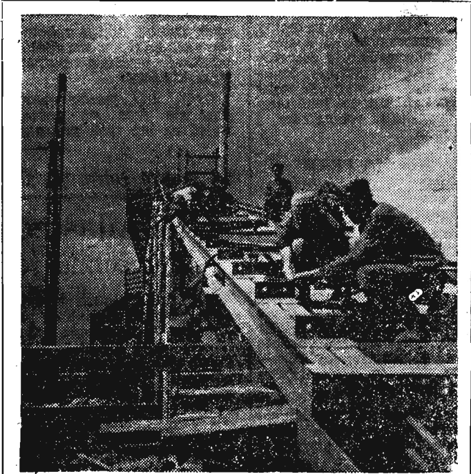
Na terenie Kombinatów Nowa Huta powstaje m. in. centralna betoniarnia, która będzie wyrabiać ok. 1.600 metrów sześciennych betonu w ciągu doby. Na zdjęciu: Brygada Jerzego Szufity (wyk. 190 proc. nowej normy) z „Mostostalu”, przy montażu transportera do widocznej w głębi sortowni kruszywa. CAF — fot. Zygm. Wdowiński.
