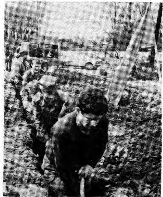
Prace ziemne na przyszłym targowisku miejskim w Przemyślu. Fot. R. PAWŁOWSKI
