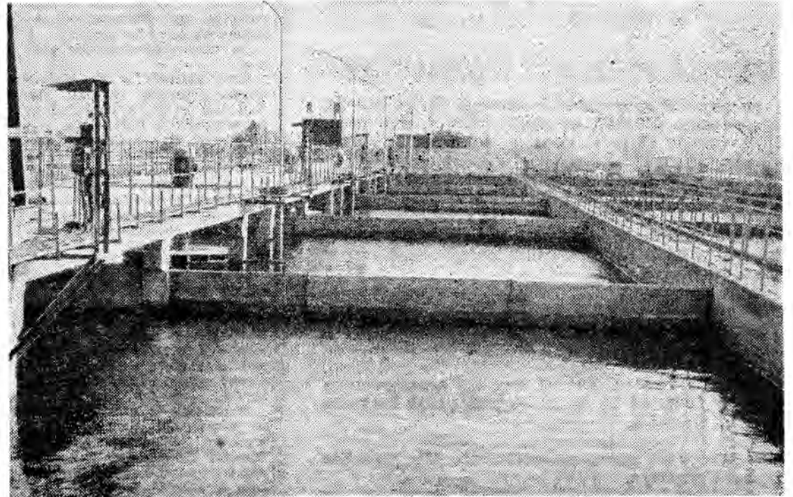
Fragment przemysłowej oczyszczalni ścieków.
