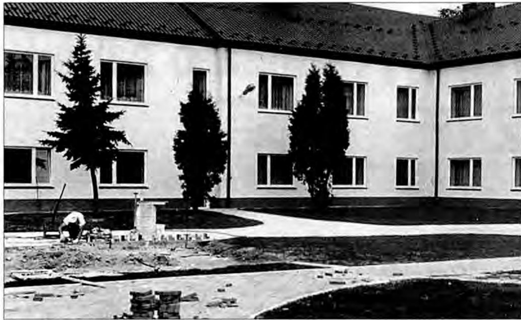
Układanie kostki chodnikowej przed hospicjum
