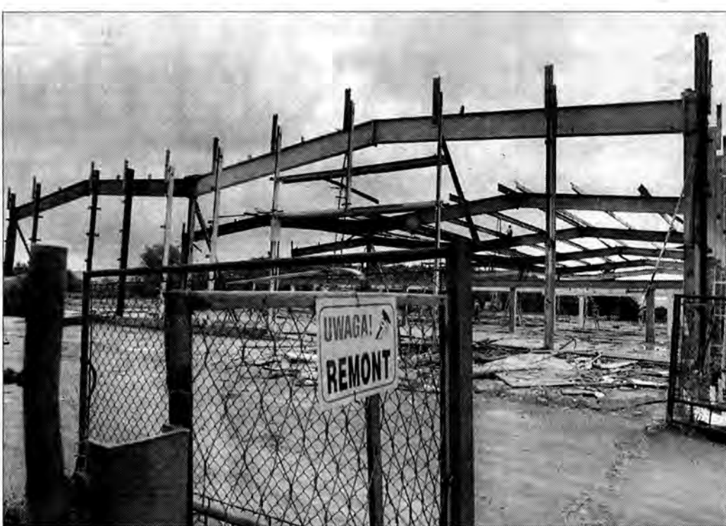
Firma Stand Sp. z o.o. kończy oczyszczanie placu budowy, na którym roboty rozpoczną się już w połowie tego miesiąca.
