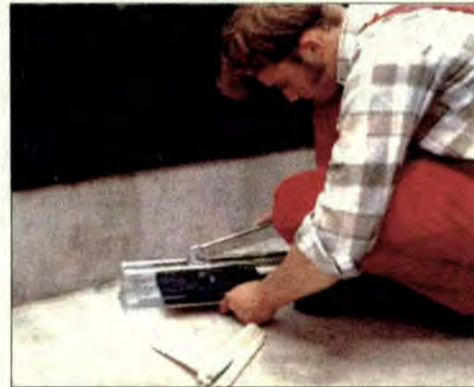
Docinanie płytek przy użyciu maszyny do cięcia płytek ceramicznych
