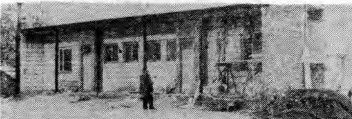
Tynkowanie budynku na stadionie, w którym znajdują się szatnia i umywalnia dla zawodników.
