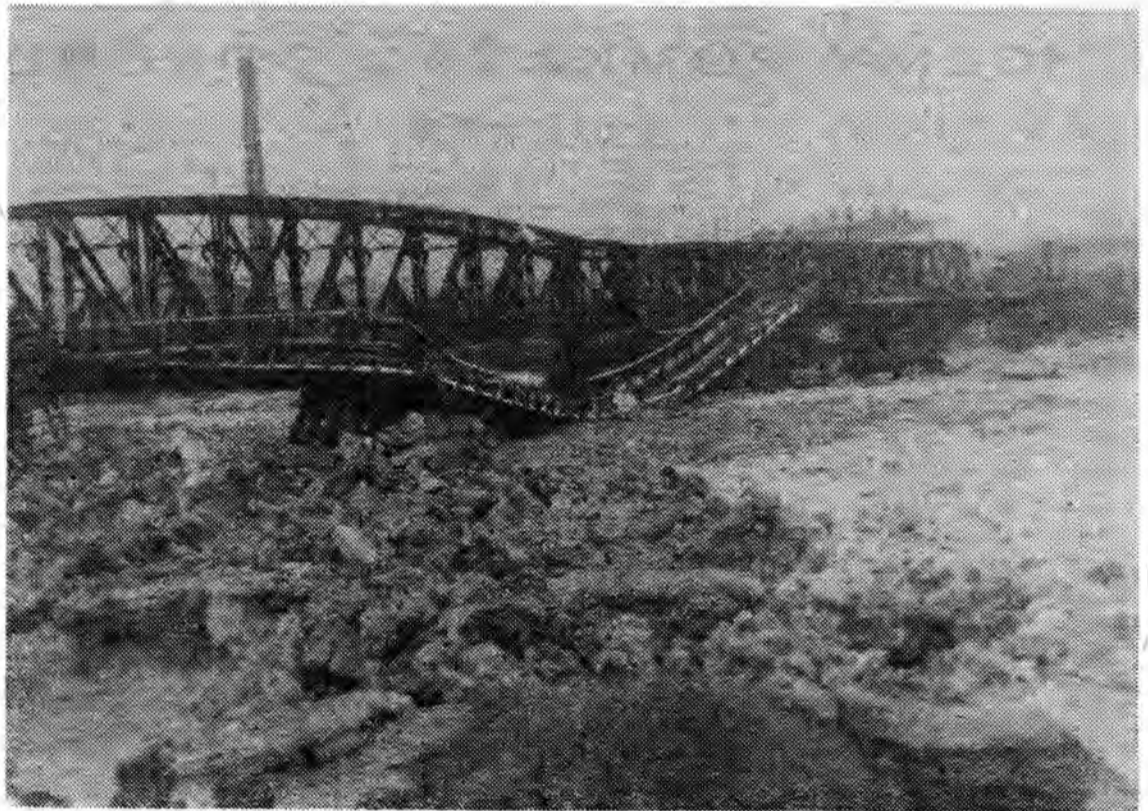
Rok 1948. Kra lodowa zrywa most drogowy na Sanie w Przemyslu.
