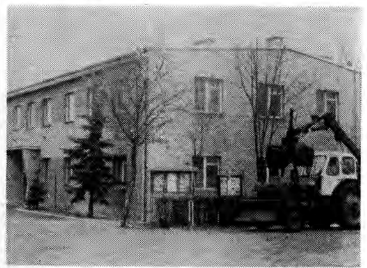
Modernizację budynku administracyjnego przeprowadziła własna grupa budowlana.
