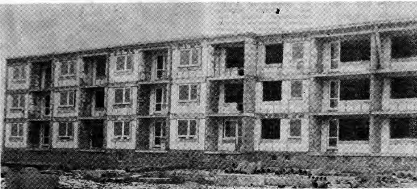
Jeszcze w tym roku zostanie oddany do użytku blok mieszkalny dla nauczycieli i pracowników gospodarstwa szkolnego.
