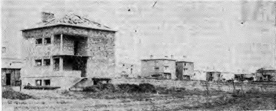
Nowe przeworskie osiedle domków jednorodzinnych „Plebanka”. Fot. TZ
