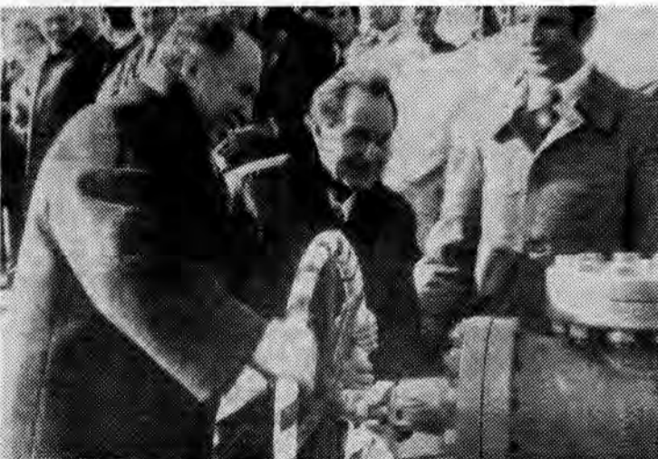
Zawór otwarty — rurociągiem popłynął gaz. Fot. TERESA ZIEMBOLEWSKA
