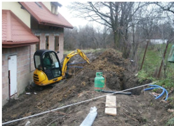
Budowa wodociągu Tyczyn - Mokra Strona
