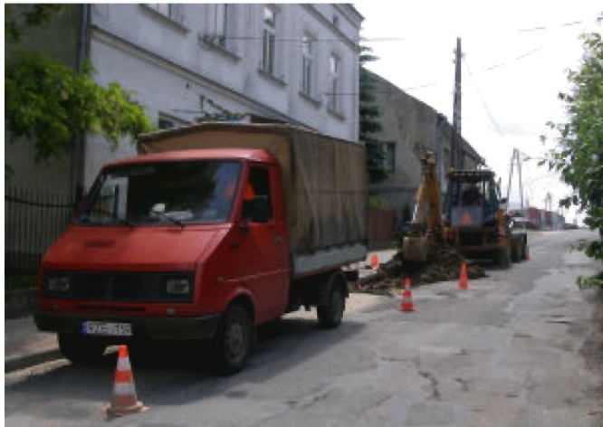
Remont wodociągu staromiejskiego w Tyczynie, ul. Kilińskiego
