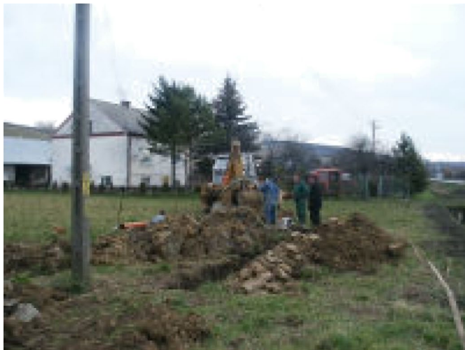
Kanalizacja Borek Stary
