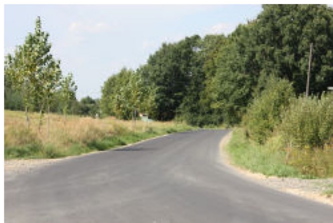
Gmina Tyczyn współfinansowała remont drogi powiatowej Tyczyn-Hermanowa-Straszylde
