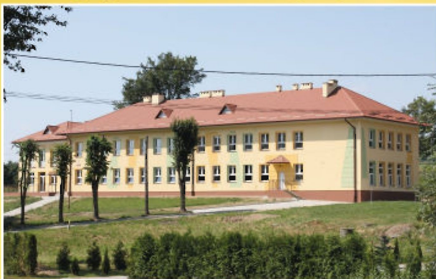
Szkoła Podstawowa w Kielnarowej po remoncie
