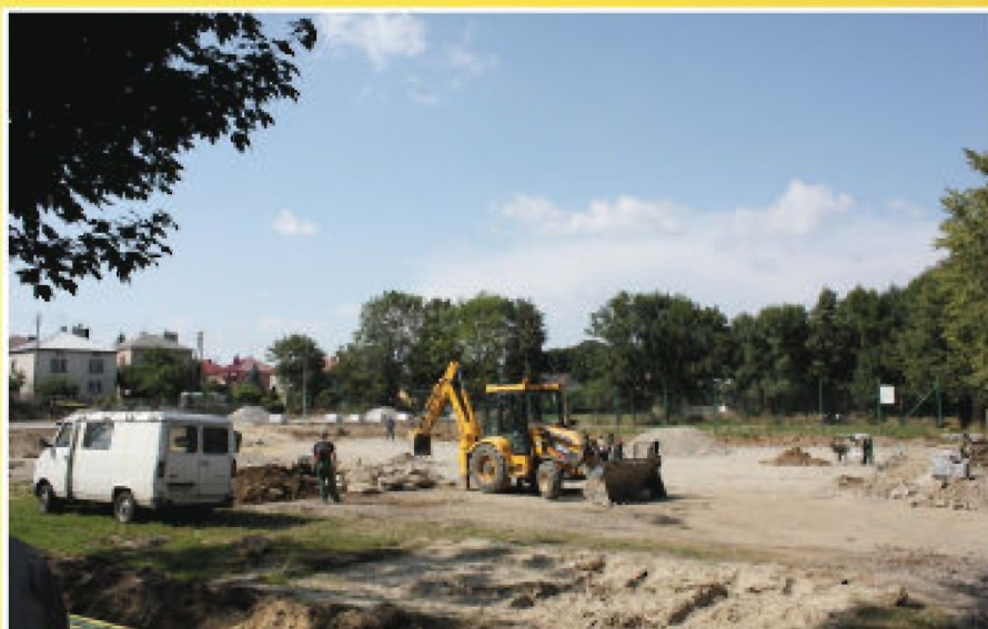
Budowa „Orlika” obok Szkoły Podstawowej w Tyczynie
