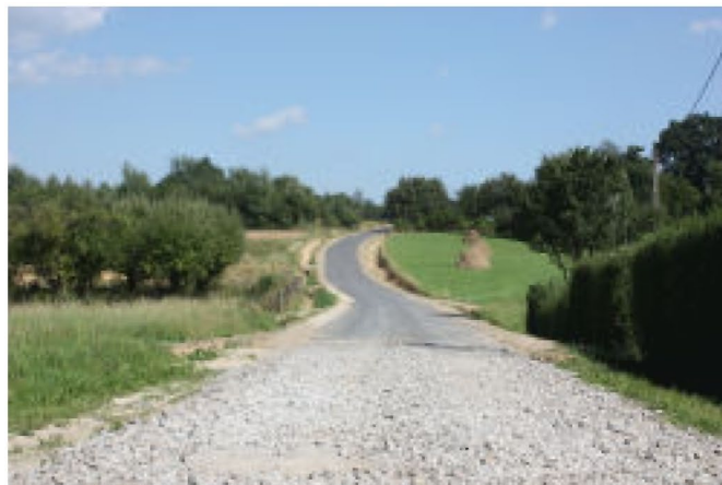
Droga gminna Tyczyn, ul. Potoki
