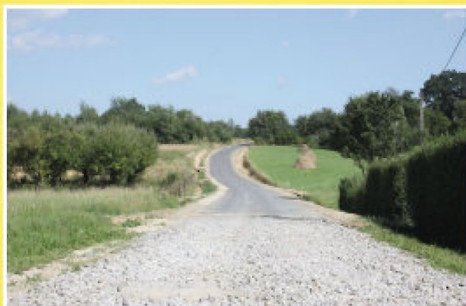
Droga gminna Tyczyn, ul. Potoki
