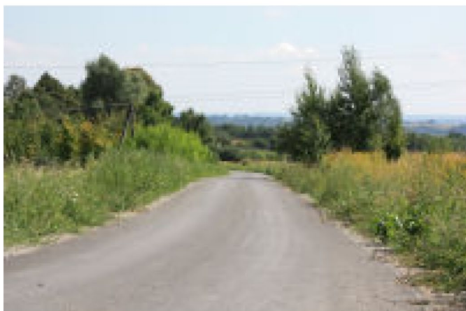
Droga gminna Tyczyn Łany
