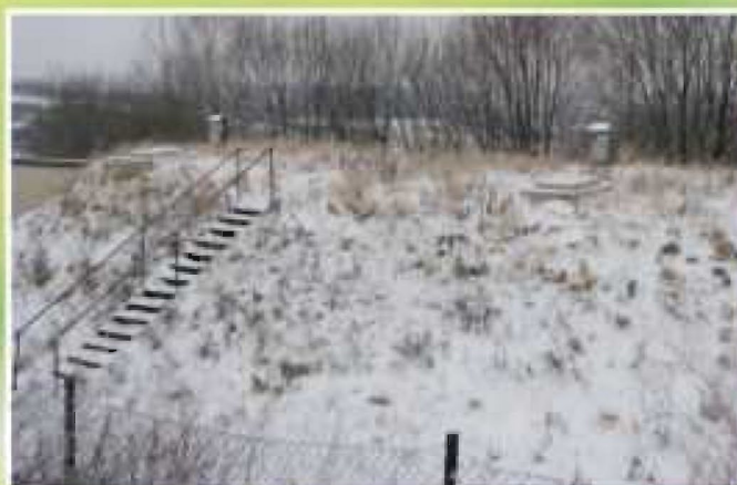
Zbiorniki wody czystej, współpracujące ze Stacją
