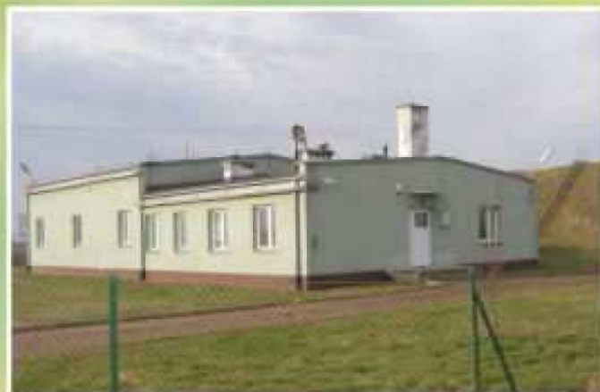
Stacja uzdatniania wody w Budziwoju
