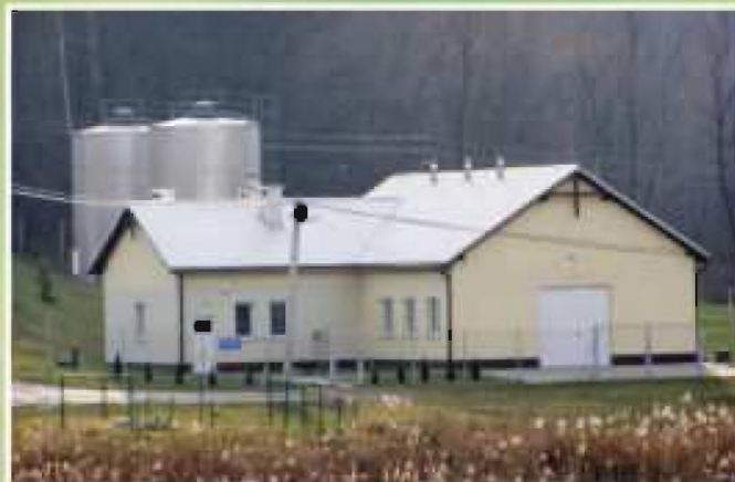
Stacja uzdatniania wody w Tyczynie
