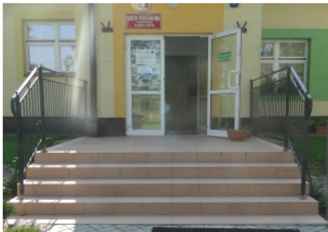
Wyremontowane schody wejściowe do szkoły podstawowej w Borku Starym
