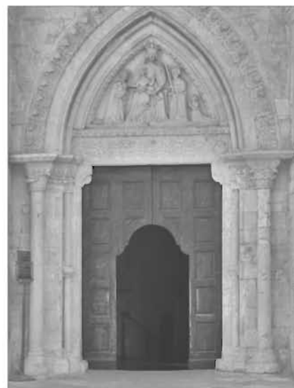
Drzwi wejściowe do kościoła w Monte Sant' Angelo (Fot. tb)
