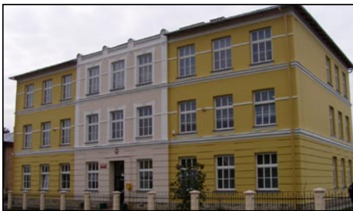
Nową elewację zyskał już m.in. budynek Gimnazjum w Haczowie oraz...
