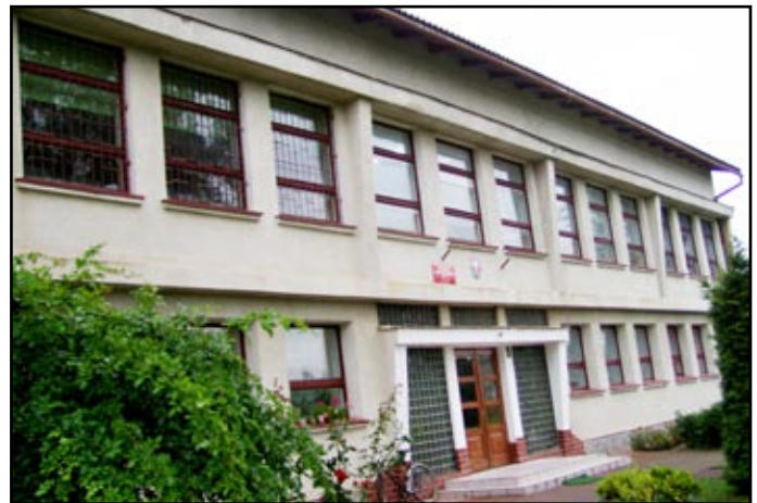
Już niedługo prace dociepleniowe rozpoczną się w SP Nr 4 w Izdebkach
