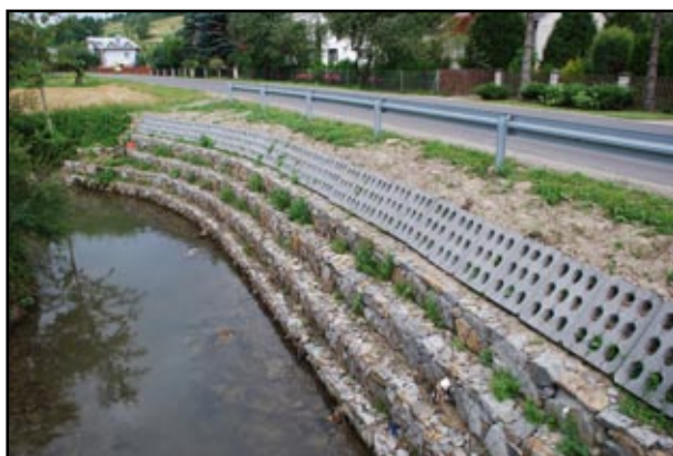
Zabezpieczone osuwisko przy drodze powiatowej w Hłudnie
