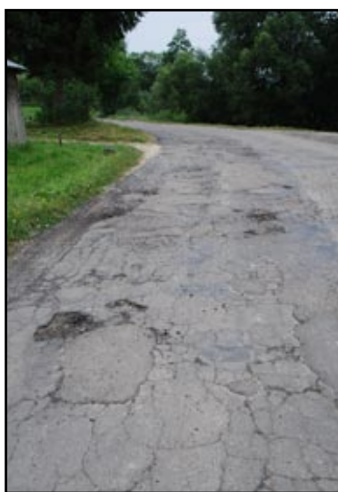
Droga powiatowa Barycz - Nozdrzec przed remontem
