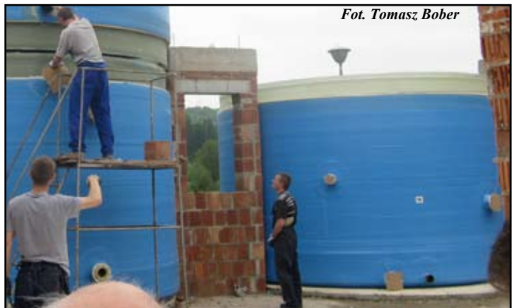
Prace przy budowie oczyszczalni ścieków
