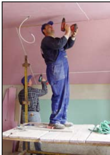
Prace przy budynku szatni w Wesolej
