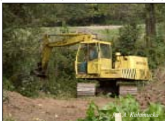
Firma „Hydrogeowiert” z Przemysła przy budowie kanalizacji w miejscowości Nozdrzec
