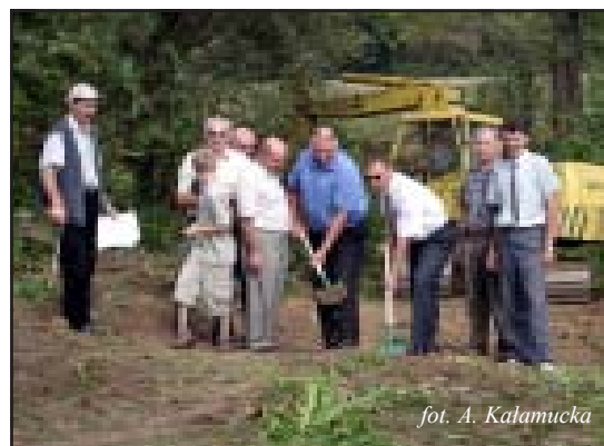
Oficjalne rozpoczęcie inwestycji przez Wójta Gminy oraz Zarząd Społecznego Komitetu Kanalizacji wsi Nozdrzec
