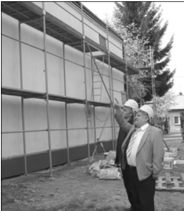
Zespół Szkół Zawodowych w Sędziszowie Młp. został ocieplony i zyskał nową elewację.
