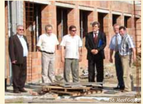
Wizytowanie budowy nowej szkoły
