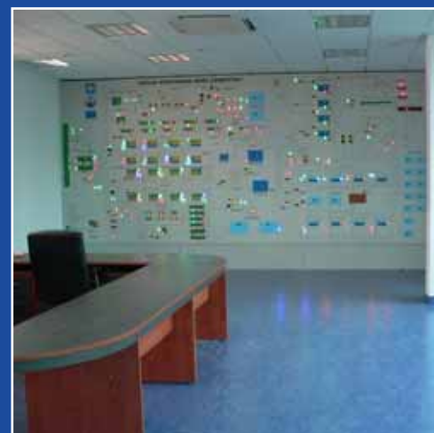
Tablica synoptyczna Centralnej Dyspozytorni w NBT
