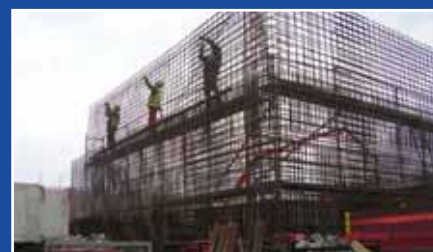
Budowa nowego zbiornika wyrównawczego wody
