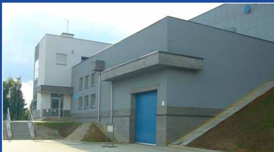
Budynki technologiczno-gospodarcze przy zbiorniku wyrównawczym wody przy ul. Krakowskiej
