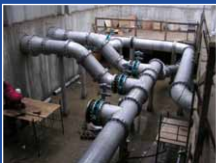
Budowa rurociągów technologicznych zbiornika wyrównawczego wody
