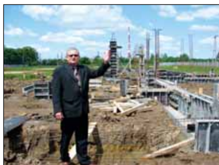
Przewodniczący Tadeusz Dudek na budowie szkoły
