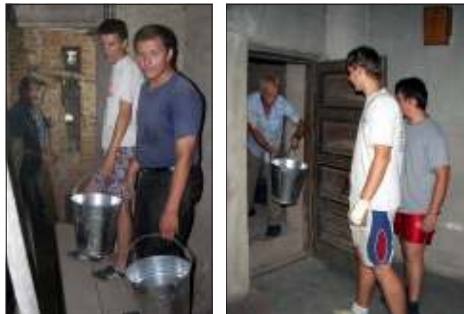
Parafianie ze Świlczy przy pracach porządkowych na kościelnym strychu (24 lipca 2007 r.). Fot. A. Szary
