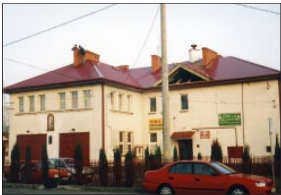
Nowy dach na Domu Strażaka w Bratkowicach.
