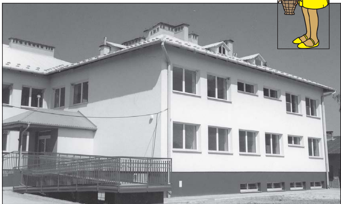
Budynek nowego przedszkola w Bratkowicach.
