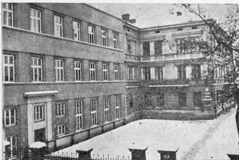
Budynek szkolny główny
