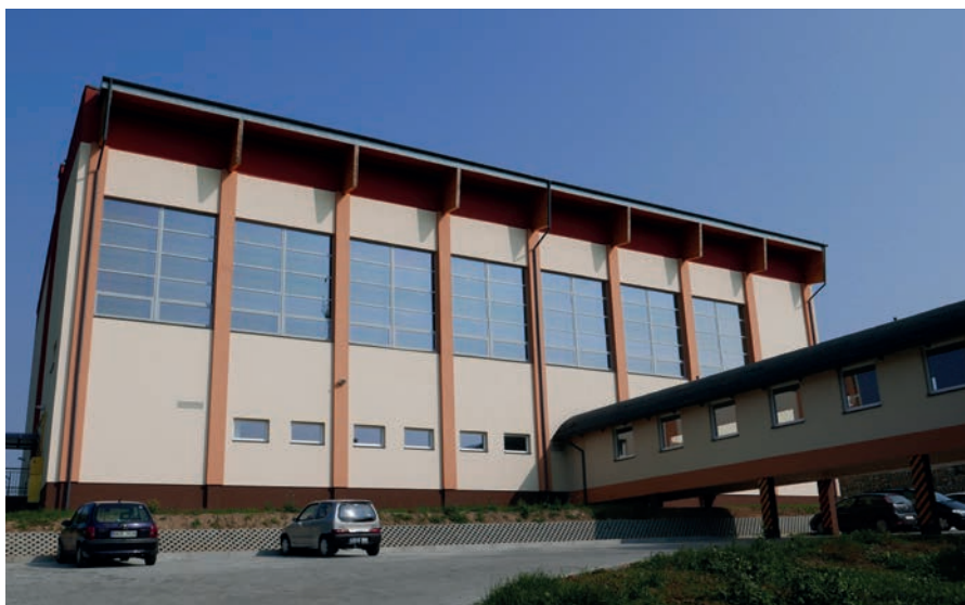
Pięć lat trwała budowa sali gimnastycznej
