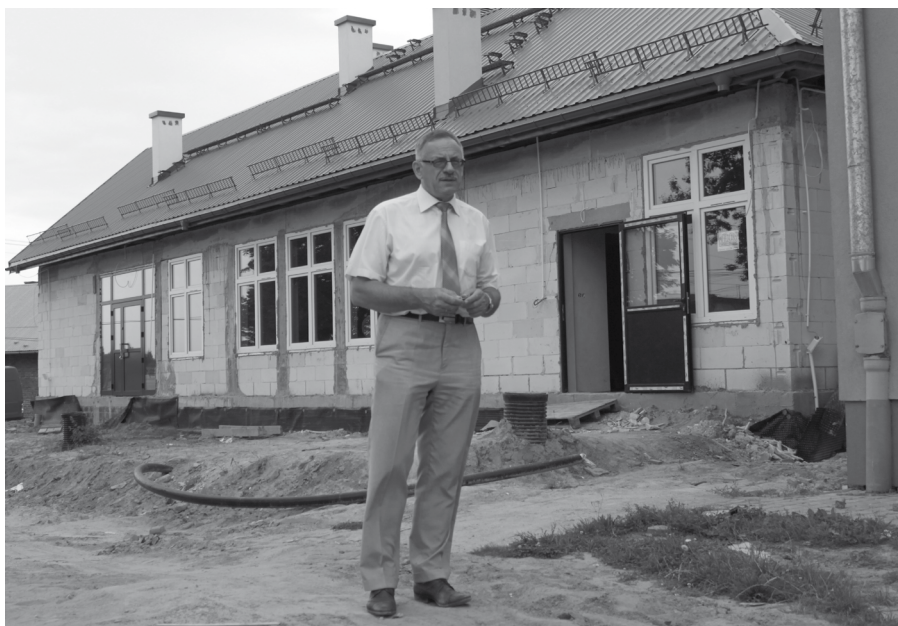
Budynek powstającego przedszkola w Kosinie, fot. Kinga Cyran
