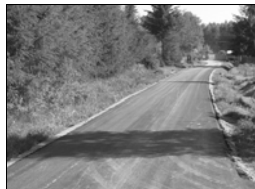
Przebudowa drogi gminnej Ruda - Zagacie
