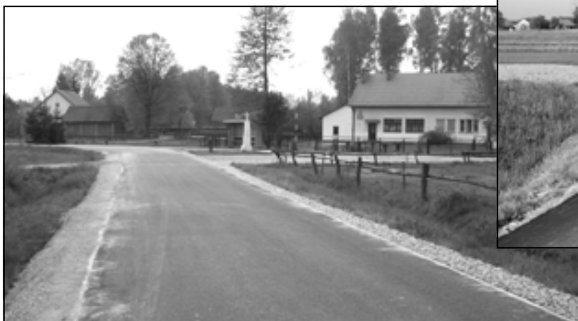
Przebudowa drogi gminnej Cierpisz - Zajezerze
