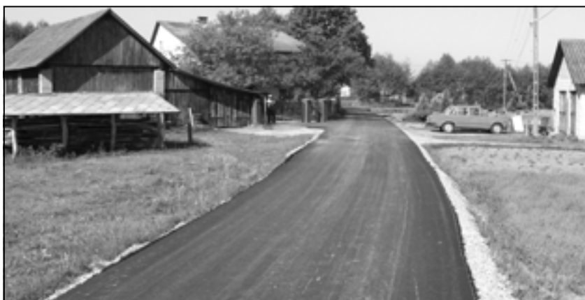
Przebudowa drogi gminnej Wolica Piaskowa - Potok
