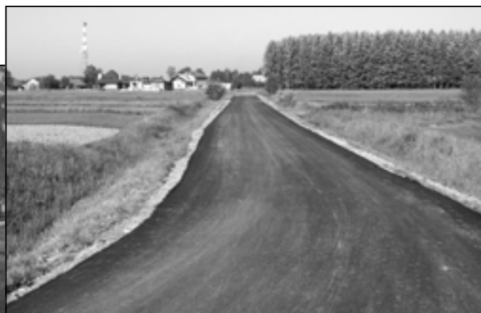
Przebudowa drogi gminnej Klęczany - Majdan (poprzeczka)
