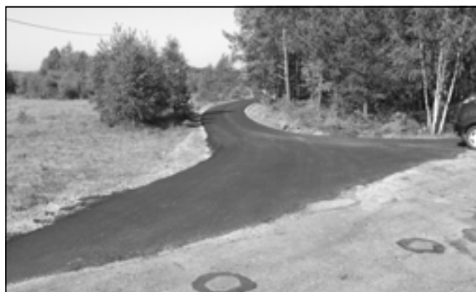
Przebudowa drogi gminnej Czarna Sędziszowska - Stara Wieś
