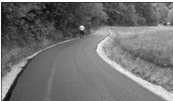
Remont drogi gminnej Zagorzyce na Jaworka
