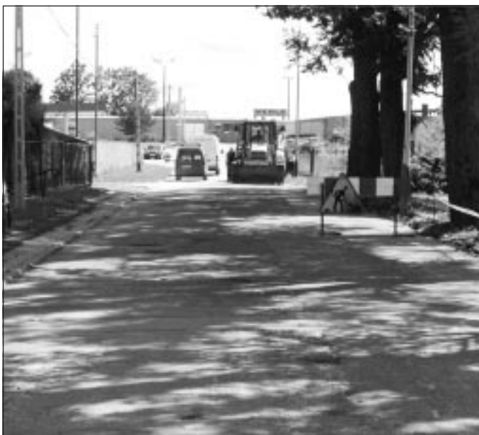
Rozpoczęto remont Alei 1000-lecia w Śędziszowie Młp., na długości 600 m zostanie wymieniony krawężnik oraz położona nawierzchnia bitumiczna, koszt inwestycji – 210.000 zł. Jeszcze w sierpniu br. ulica ta będzie miała również nowy chodnik.
