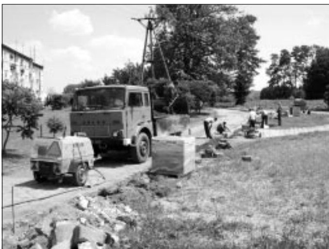
W Górze Ropczyckiej trwają prace przy budowie odcinka 300 m drogi gminnej w kierunku bloków, inwestycja będzie kosztować 58.000 zł.
