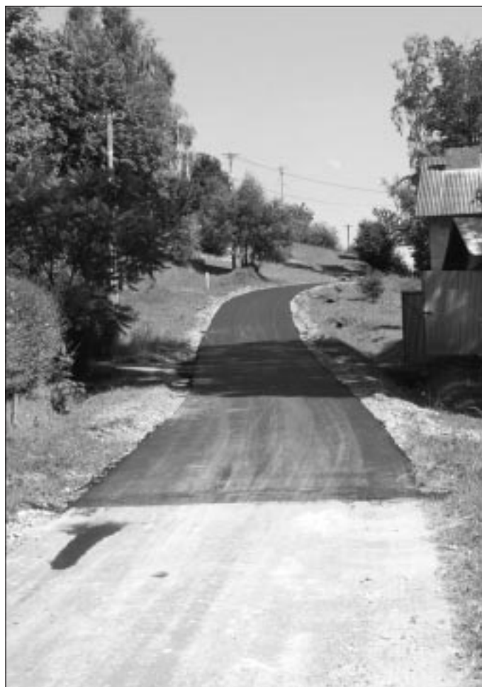
Budowa drogi w Szkodnej na tzw. Sołtysówkę. W bieżącym roku asfalt została położony na odcinku 300 m za kwotę 70.000 zł.
