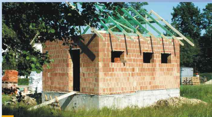
Budynek przepompowni w stanie surowym, stąd woda będzie tłoczona m.in. do przysiółka Sobótki.
