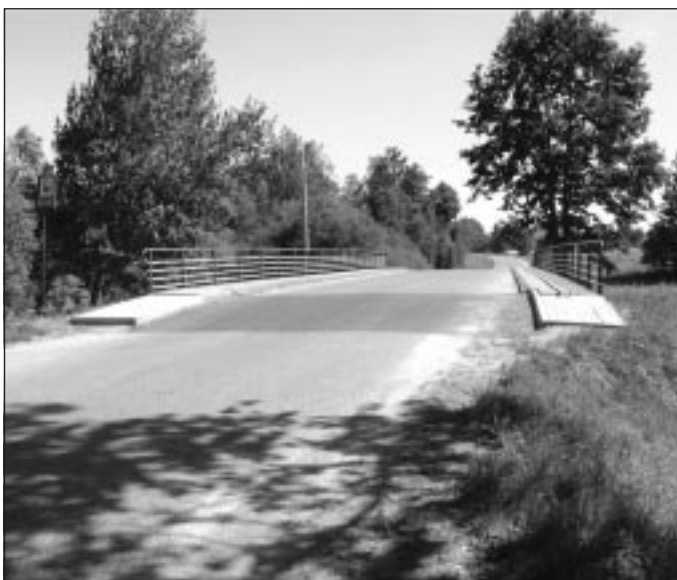
Most w Borku Wielkim k/kościół po remoncie. Koszt inwestycji wyniósł 50.000 zł.
