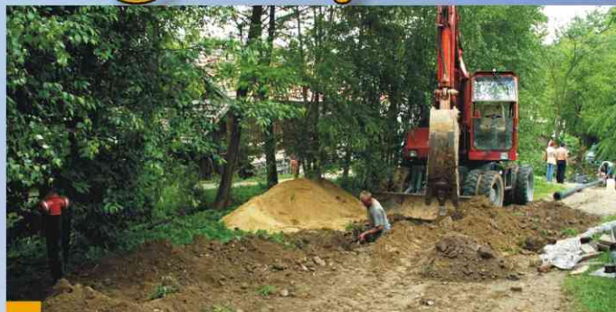
Budowa wodociągu w Zagorzycach Dolnych w 2005 roku.
