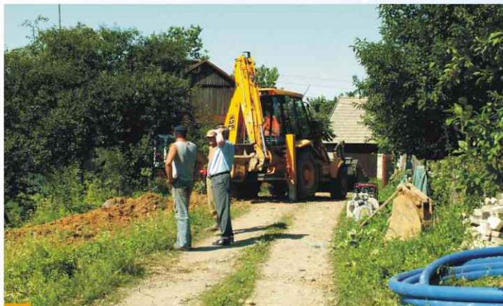
Prace przy budowie sieci wodociągowej na Malskówce w Zagorzycach Górnych, które prowadzi firma BUDOMONT Łańcut. Wiele wykopów z uwagi na ukształtowanie terenu wykonywanych jest ręcznie.
