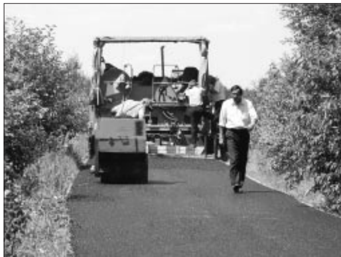
Budowa drogi gminnej do przysiółka Poręby w Borku Wielkim. W roku ubiegłym wykonano 500 m tej drogi a w bieżącym kolejne 600 m za 120.000 zł.
