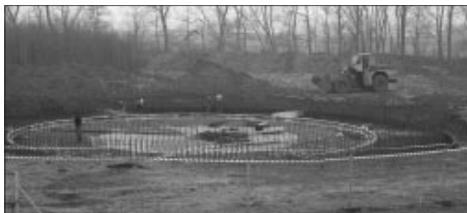
Ruszyła rozbudowa oczyszczalni ścieków.
