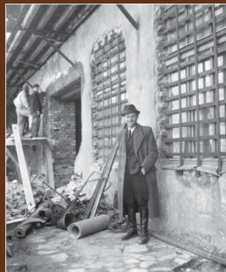
Michał Kędziora dogląda prac renowacyjnych w mieście
