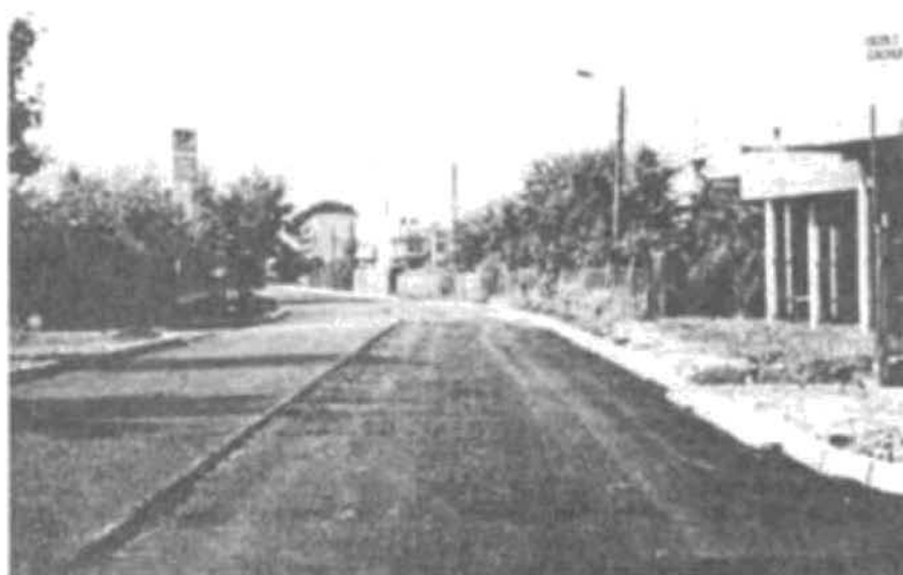
Modernizacja ulicy Rejtana w Jedliczu
