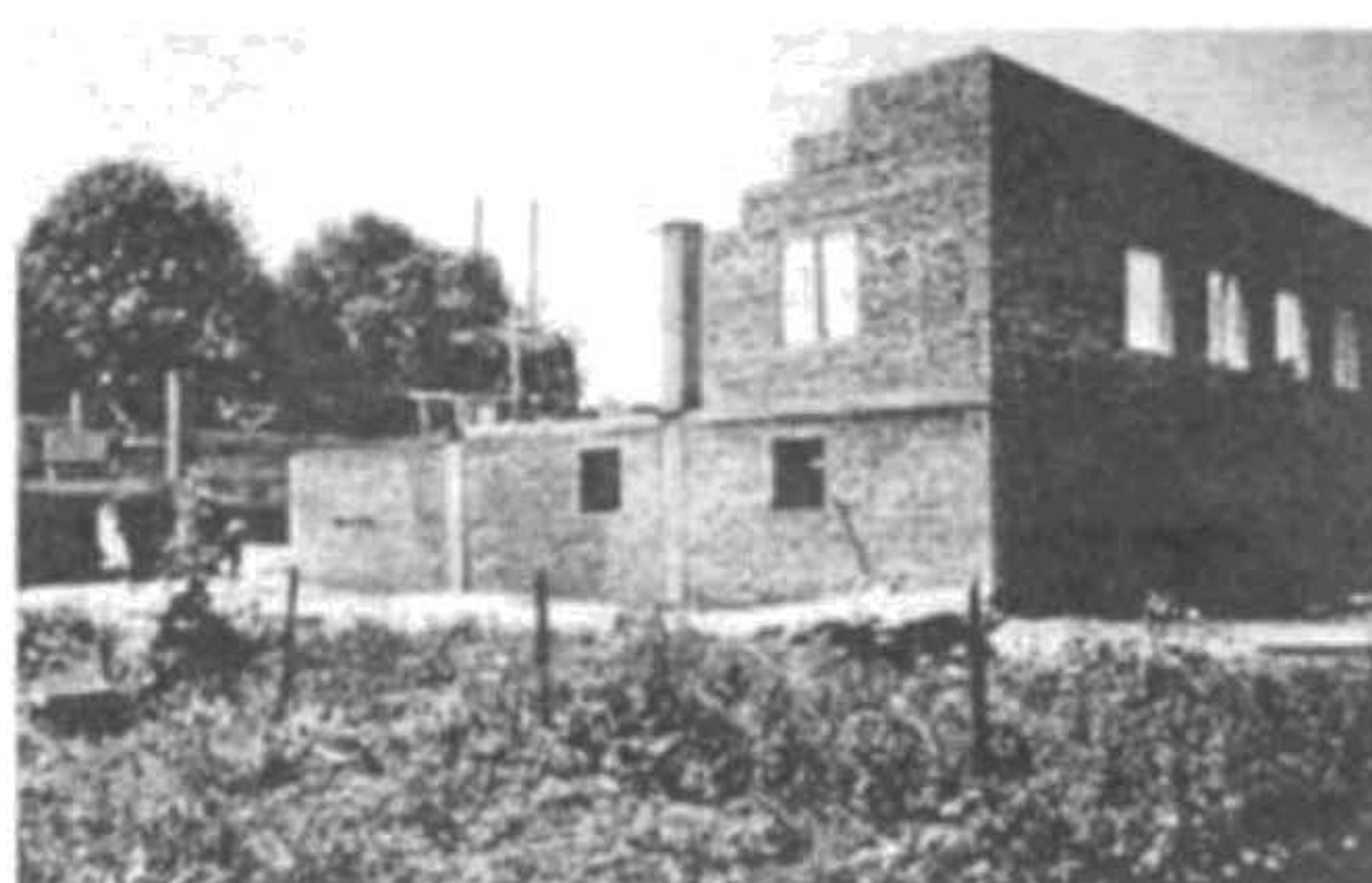
Budowa hali sportowej - 10.06.2000r.
