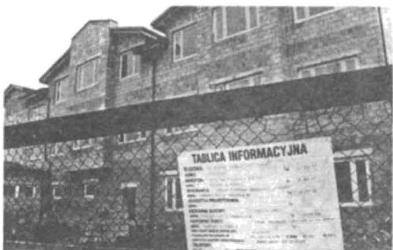
Budowa szkoły w Moderówce
