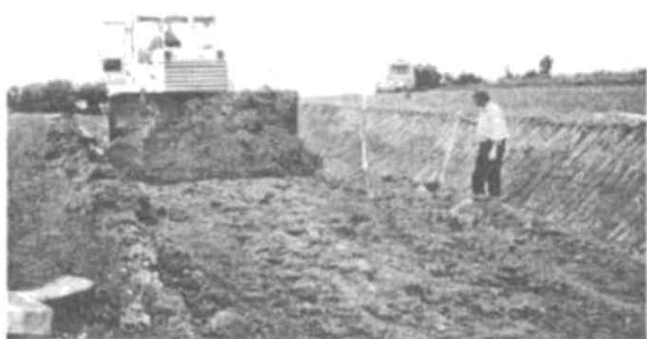
Budowa drogi rolniczej w Podniebylu
