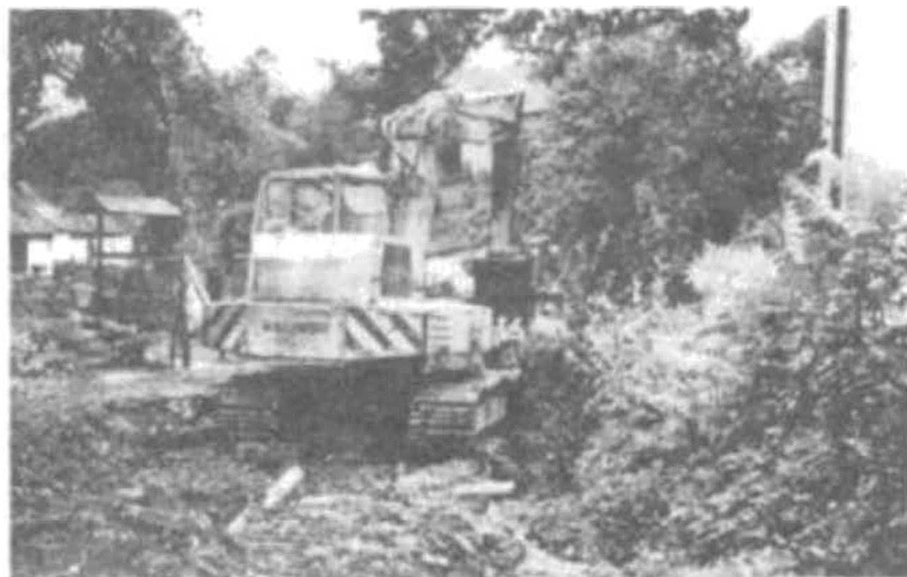
Budowa kanalizacji sanitarnej w Potoku
